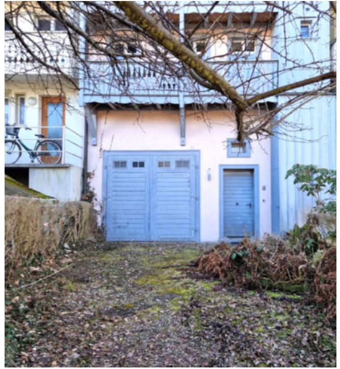
Der Aussenparkplatz vor dem elektrischen Garagentor
